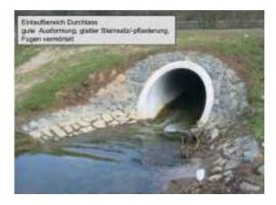
Raue Sohle im Einlaufbereich, ohne Betonbettung; Böschungsbefestigung und "Kranz" in Beton
