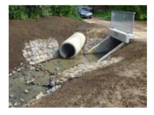
Nachbettsicherung (Pfahlreihe, Steinschüttung, Böschungsbefestigung)
